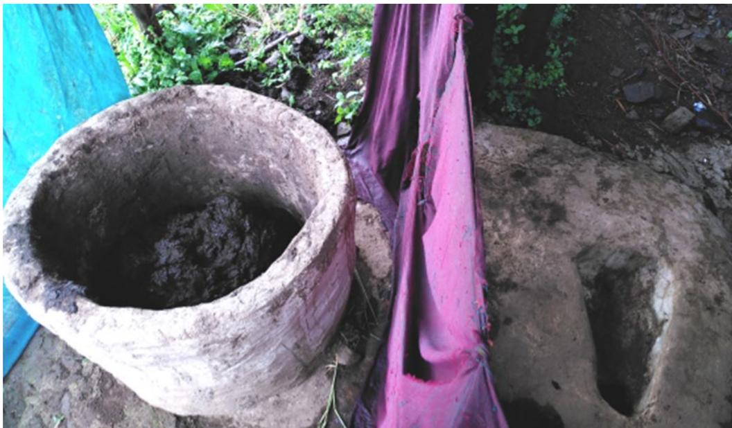
**Abbildung 18** Zulauf der Biogasanlage: Mischer links und Toilette rechts (Quelle: Eigenes Foto)
